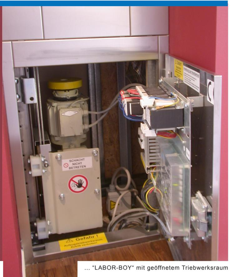
... "LABOR-BOY" mit geöffnetem Triebwerksraum
